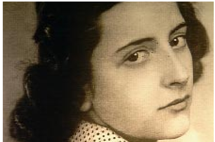
Vera Dotan war 13 Jahre alt auf der Flughafen-Baustelle
